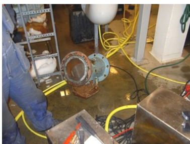
Utbyte av rostangripet filter
