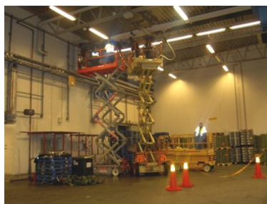
Montage av ventiler
